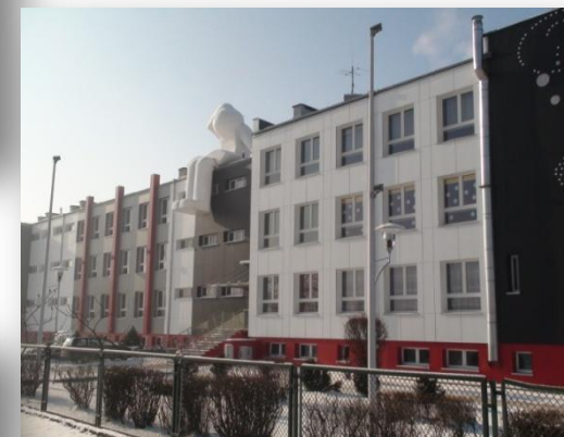
Termomodernizacja Szkoły Podstawowej w Deszcznie
