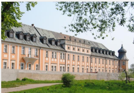
Termomodernizacja obiektów Wyższego Seminarium Duchownego w Paradyżu.
