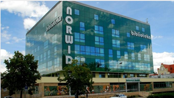
Termomodernizacja biblioteki im. C.K.Norwida w Zielonej Górze. Źródło: www.zielonanews.pl
