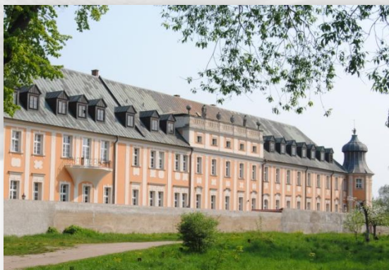
Termomodernizacja obiektów Wyższego Seminarium Duchownego w Paradyżu.
