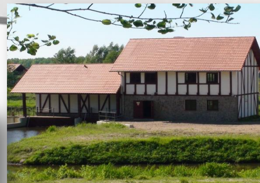
Mała elektrownia wodna na rzece Szprotawa
