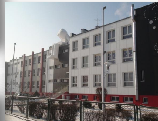
Termomodernizacja Szkoły Podstawowej w Deszcznie
